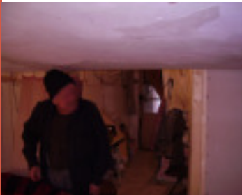
Hauteur sous plafond insuffisante
