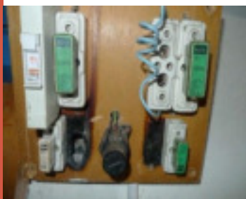
Branchements d'électricité vétustes
